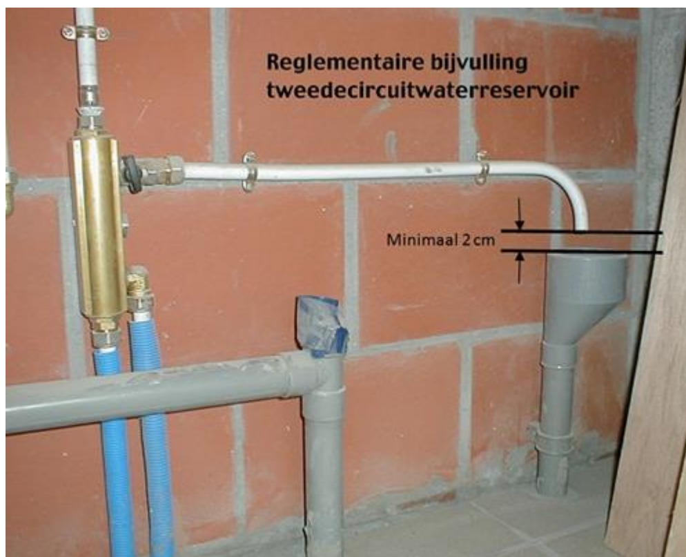
Figuur 3: AA-beveiliging bijvulling installatie
