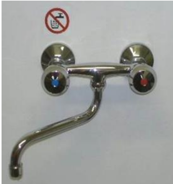
Figuur4: wanverbinding mengkraan
