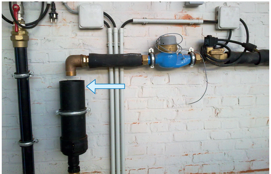
Correct bijvulstelsel voor de regenwaterput
