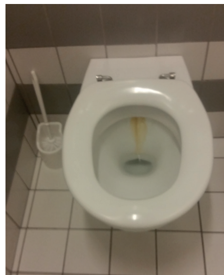
Een WC waar het water doorloopt, is dikwijls te herkennen aan de bruine streep (van het ijzer in het water)
