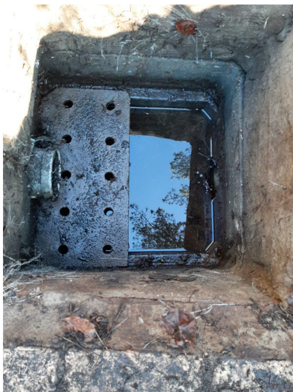
Afbeelding: ter plaatse gemetste voorfilter
